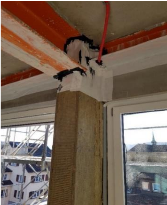
Luftdichte Bauteil-Anschlüsse
